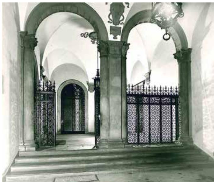
3a. Cannello in ferro battuto realizzato da Pasquale Franci.
